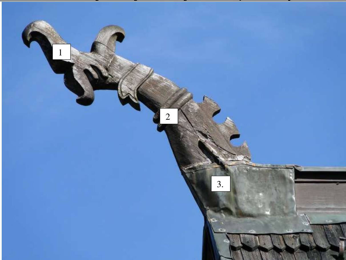
Ryc. 47. Smocza paszcza biały nalot (1), pęknięcie (2), deformacja blachy (3).
