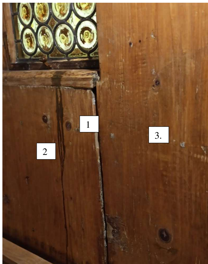
Ryc. 52. Wnętrze kościoła pęknięcie (1), wtórne uzupełnienie (2).
