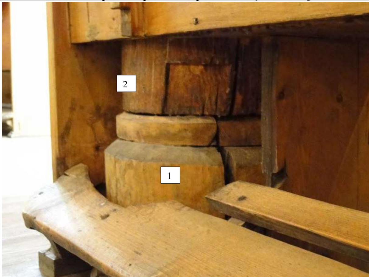
Ryc. 52. Wnętrze kościoła pęknięcie (1), wtórne uzupełnienie (2).
